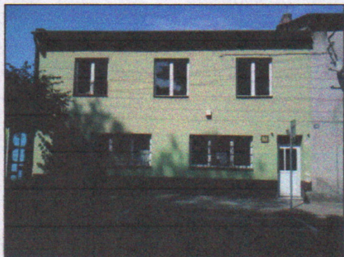
1. Widok od strony ul. Łowickiej
