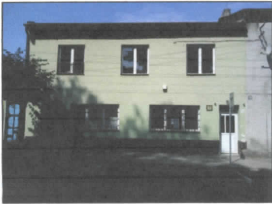
1. Widok od strony ul. Łowickiej
