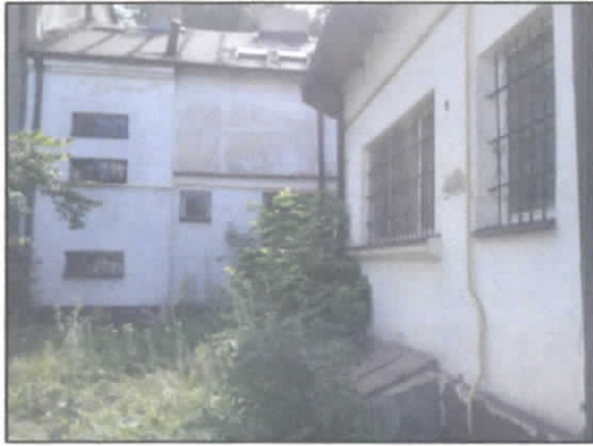
2. Budynek frontowy i oficyna – widok od podwórka
