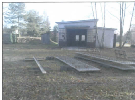
10. Budynek gospodarczy i suchy ustęp
