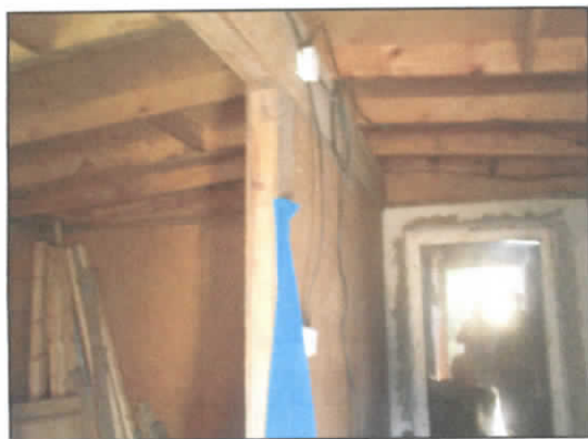
13. Pomieszczenie w budynku socjalnym, konstrukcja
