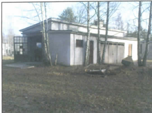
5. Budynek gospodarczy (zbrojarnia)
